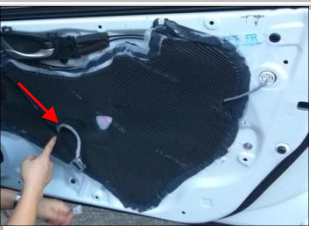
2.11、线束从箭头两处穿出，接头还原安装； 穿线时注意切勿刮蹭升降玻璃
