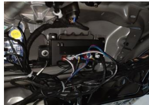
4.4 安装好 ECU 后接上线速，如图所示为接线完成
