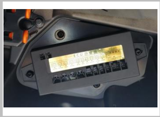
4.3 图示为 ECU 支架已经安装完成
