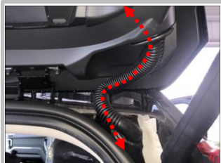
3.1 把驱动盒线、正极线、解码器控制线穿过波纹管
