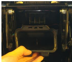
1.8 拆下空调出风口
