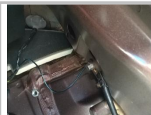
3.12 接负极:在右侧装饰板内找到螺丝,把我们的负极线搭上,松动螺母不用拆下,卡紧后再还原装紧螺母;
